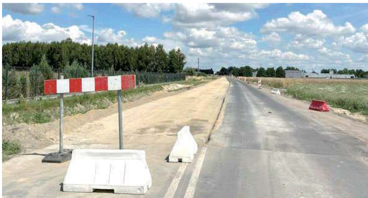
Podbudowa jednej strony ul. Polnej jest gotowa
