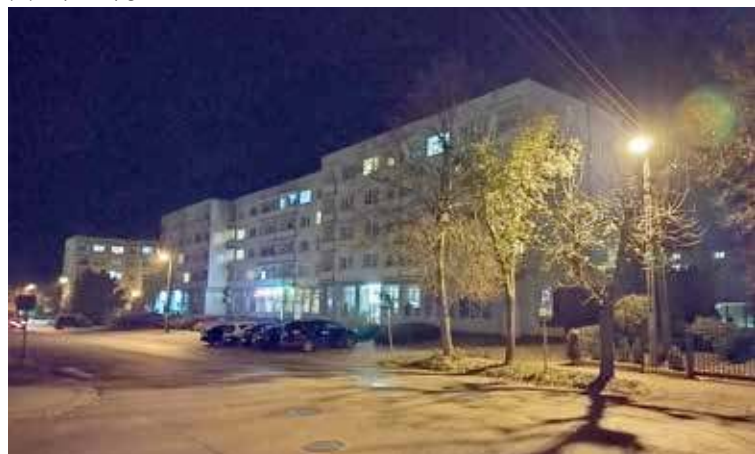
Lampa póki co oświetla drzewo i kawałek jezdni. Niestety nie jest to odcinek, gdzie znajdują się pasy
