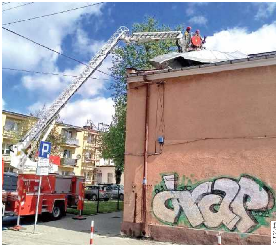
Przy użyciu podnośnika oraz sprzętu do prac na wysokości strażacy przymocowali oderwane elementy poszycia do konstrukcji dachu
