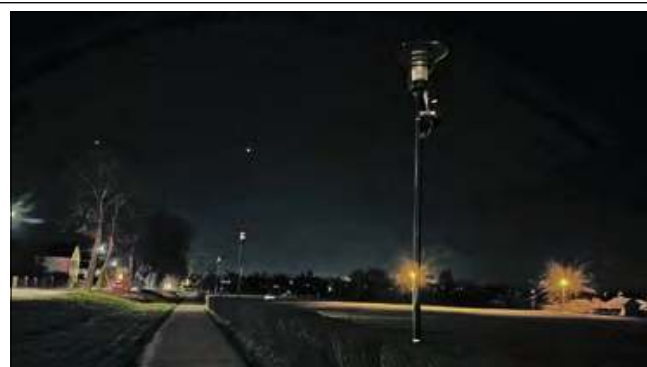
Lampy przy ścieżce rowerowej nie świecą.
