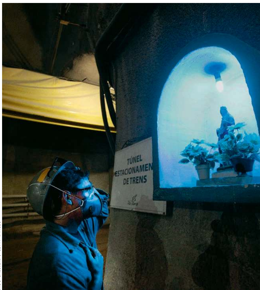
Przy budowie linii metra w Rio de Janeiro, 2012 r.
