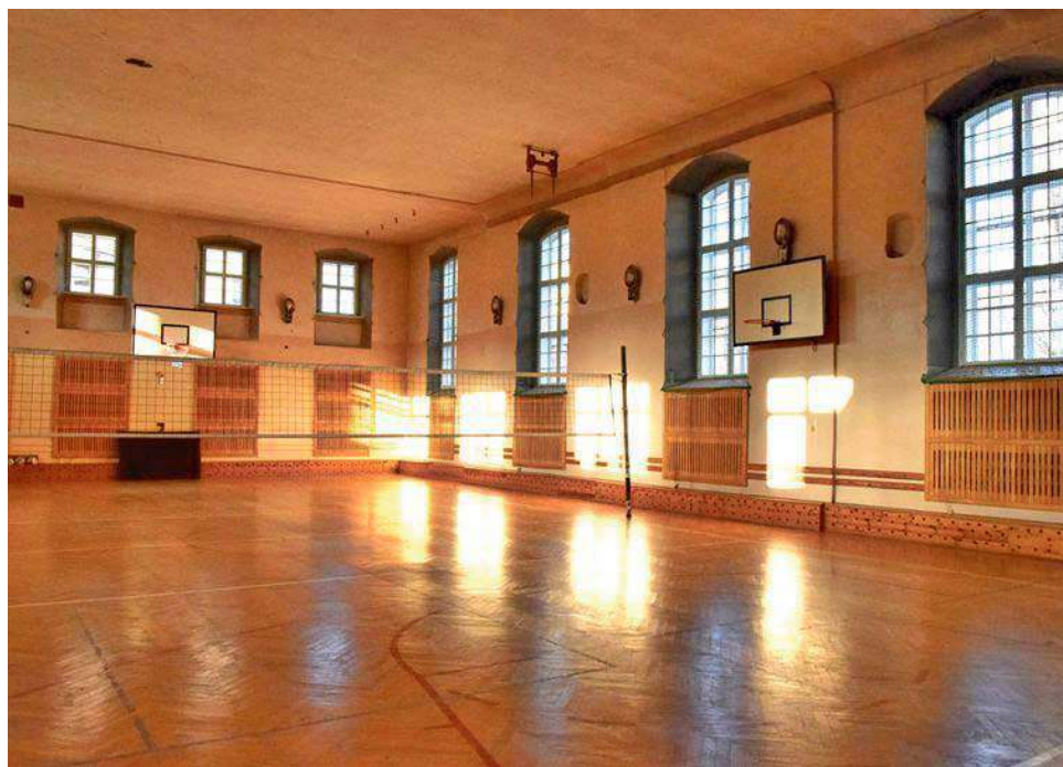
Zakres inwestycji obejmuje m.in. remont sufitu, ścian, uzupełnienie ubytków w parkiecie
