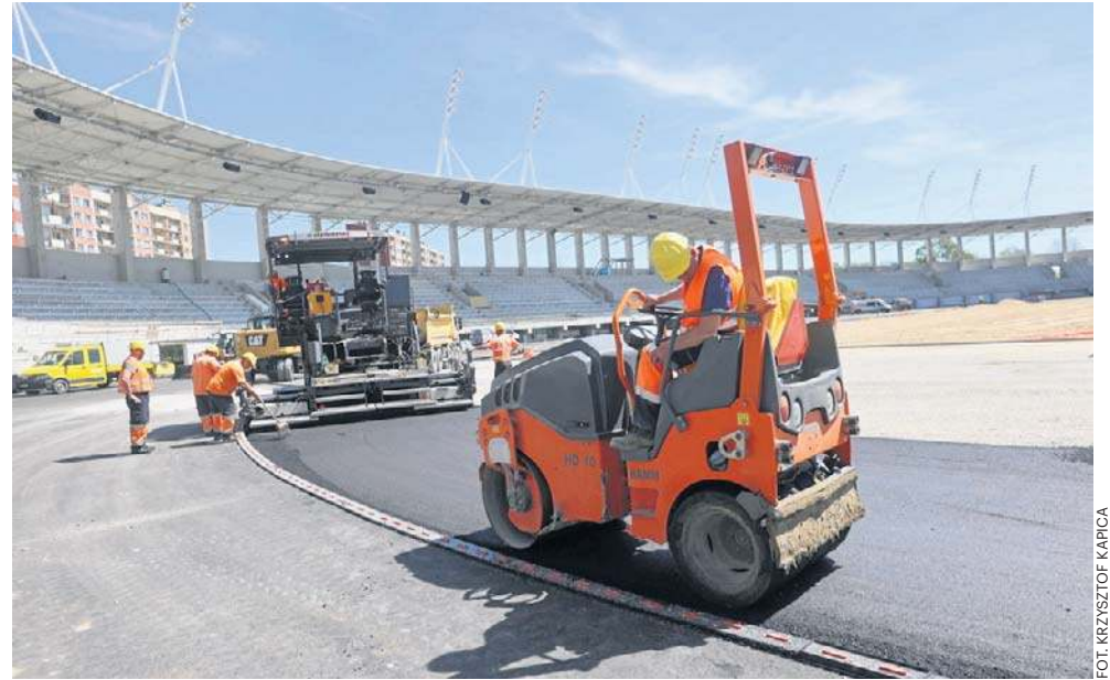
W Podkarpackim Centrum Lekkiej Atletyki w Rzeszowie trwają prace przy układaniu podłoża pod bieżnię. Więcej zdjęć na nowiny24.pl
