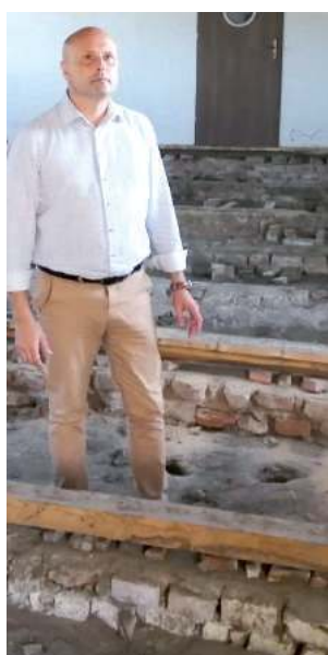
Wójt Tomasz Jurkiewicz sprawdza jakość wykonanych prac
