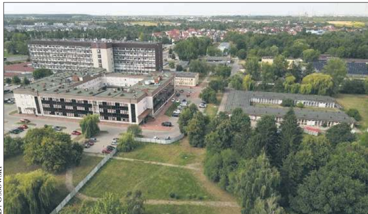
W WSzZ zmodernizowane będzie ogrodzenie i dach przychodni specjalistycznej
