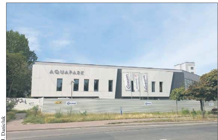
Na budynku nowej pływalni przy ul. Miodowej został już zamontowany napis „Aquapark”
