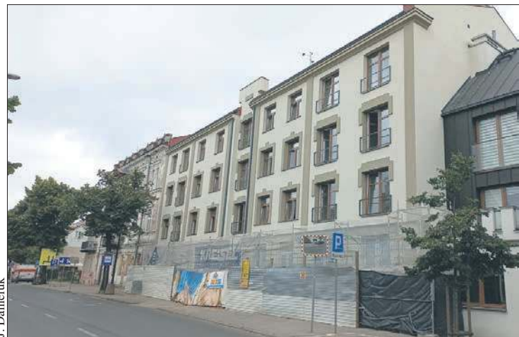
Prace budowlane przy ul. Sienkiewicza 46
