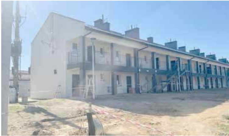
Obecnie w budynku komunalnym przy ul. Cmentarnej trwają odbiory
