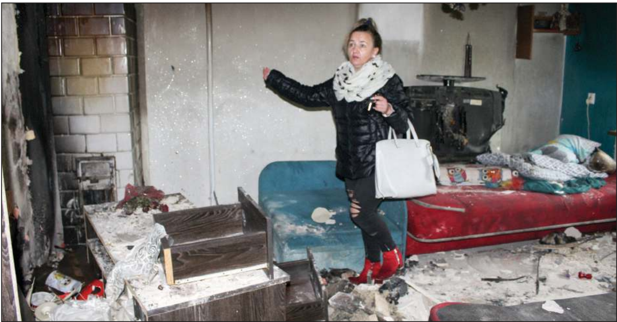
W ubiegły czwartek przy ul. Rynek Stary w Rykach doszło do pożaru mieszkania na pierwszym piętrze w budynku wielorodzinnym
