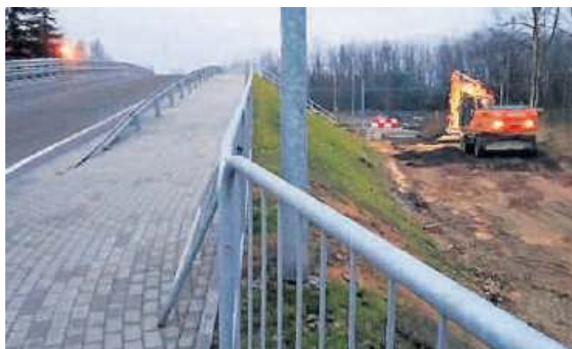
Wiadukt zastąpił dotychczasowy przejazd kolejowo-drogowy z rogatkami. Koszt budowy wyniósł ok. 3,8 mln zł
