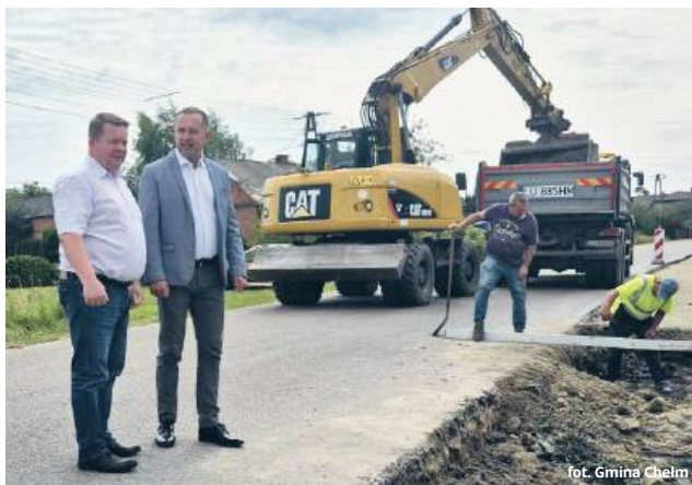
Prace drogowe w Horodyszczu
