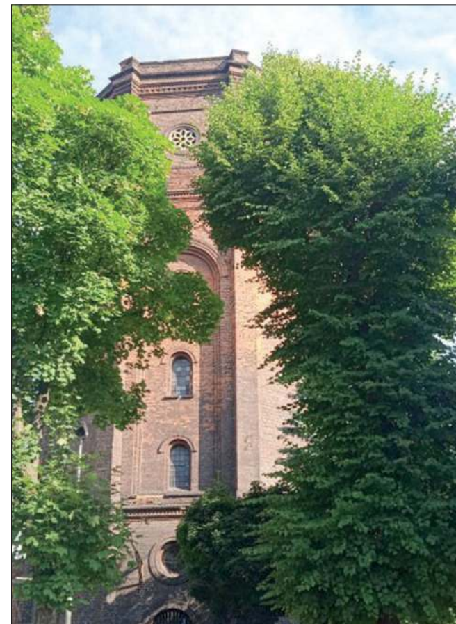
Wieża ciśnień została oddana do użytku 23.09.1874 r. i jest jednym z najstarszych tego typu obiektów na Śląsku. Jest wysoka na 25 metrów a zbiornik na wodę o pojemności 500m³ jest osadzony na wysokości 23 metrów
