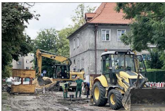
Aktualnie drogowcy pracują w rejonie przedszkola przy ul. Bema.
