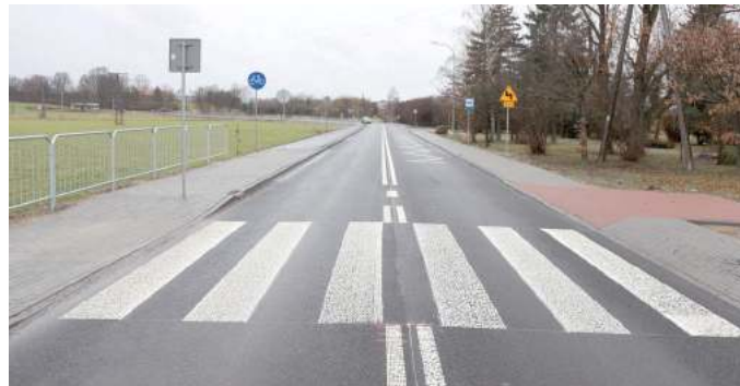
Wyremontowana droga Łucka-Kaznów (fot. Starostwo Powiatowe)
