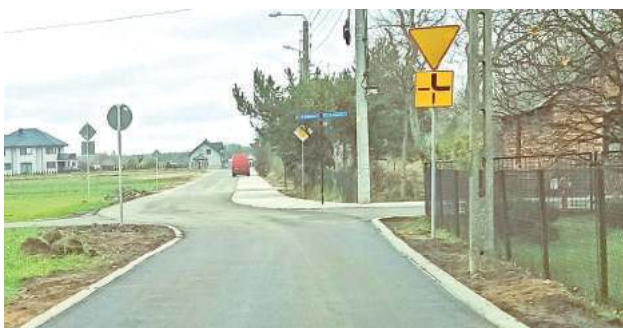
Ulica Poprzeczna po przebudowie
