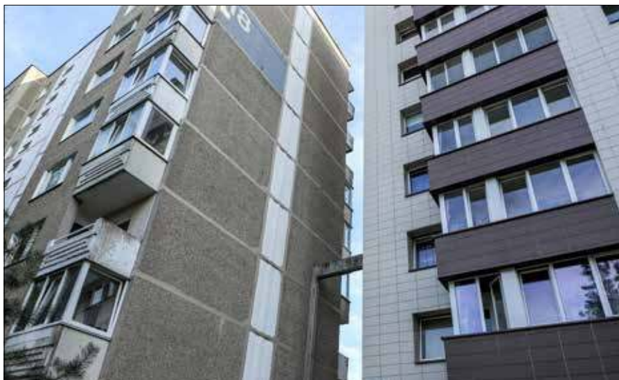
■ Modernizacja bloków wielomieszkaniowych na Litwie Fot. archiwum APVA
