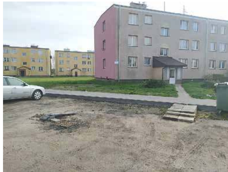
Wysoki na kilkadziesiąt centymetrów uskok powoduje, że mieszkańcy sami zbudowali dogodne dla siebie przejście
