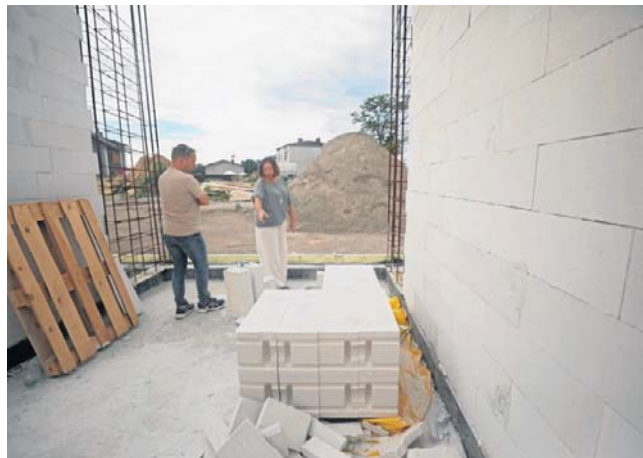
W Tychach trwa budowa hospicjum dla dzieci „TuSieTuli”
