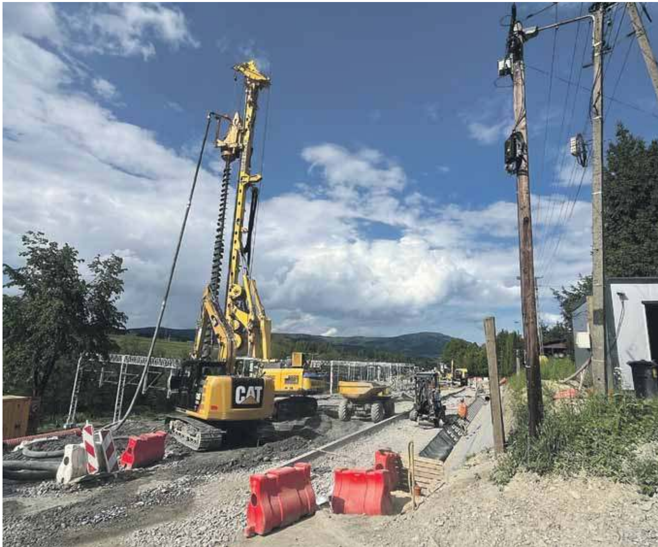
Palowanie osuwiska dobiega końca.
