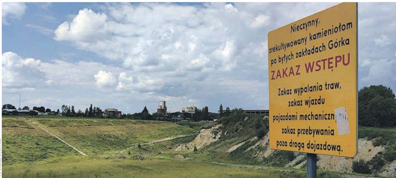
Zrekultywowany kamieniołom po dawnych zakładach „Górka” w Trzebinii
