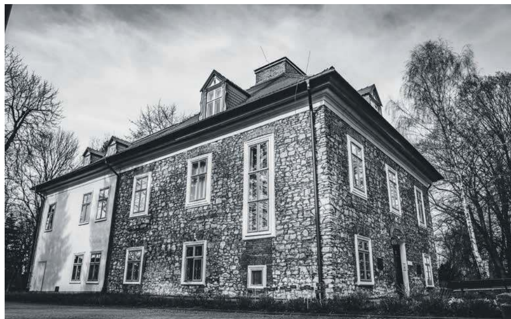
Zabytkowa część budynku powstała z lokalnego kamienia, druga część to przybudówka, która po dwóch nadbudowach zrównała się z głównym budynkiem
