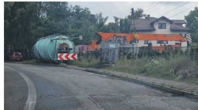
Front robót do uzdatniania gruntu przy ul. Górniczej w Trzebinie Sierszy przygotowany Fot. Michał Papiernik
