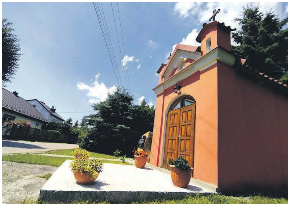
Z inicjatywy Bogdana Bukowskiego został naprawiony podest przed kapliczką w Źródłach. Według władz gminy Alwernia doszło do zniszczenia zabytku
