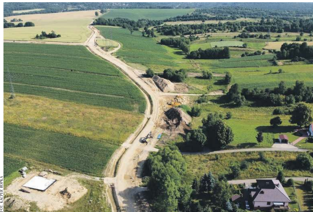
Tak wygląda budowa nowej drogi od DK 79 do terenów inwestycyjnych w Krzeszowicach
