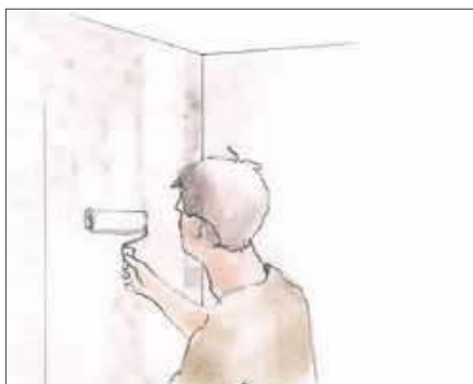
❺ Aplikacja kleju na przymocowaną wcześniej płytę akustyczną.
