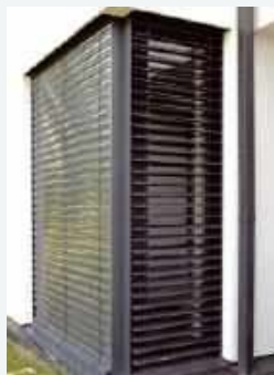
❶ Kasety i prowadnice zakryte tynkiem.
