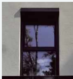
Rolety elewacyjne przymocowano do ram okien.
