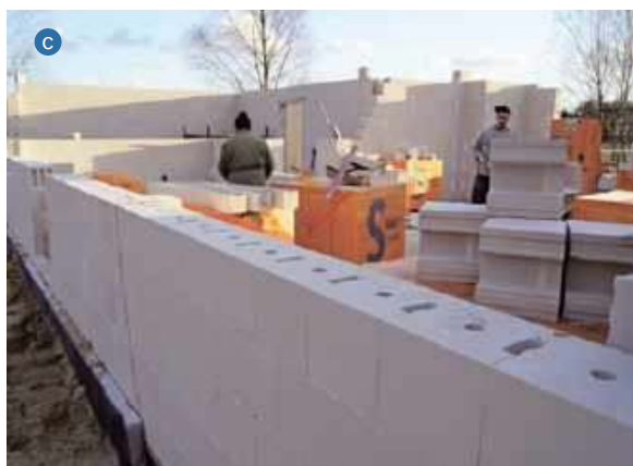
U Najpopularniejsze materiały ścienne: beton komórkowy (a TERMALICA BRUK-BET), ceramika poryzowana (b WIENERBERGER), silikaty (c H+H).
