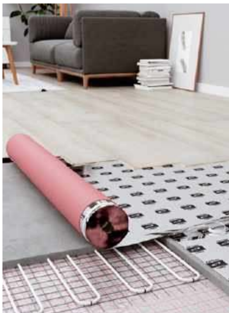
🔊 Wyroby winylowe nadają się na ogrzewanie podłogowe. W takim wypadku trzeba jednak zastosować odpowiedni podkład. ARBITON
