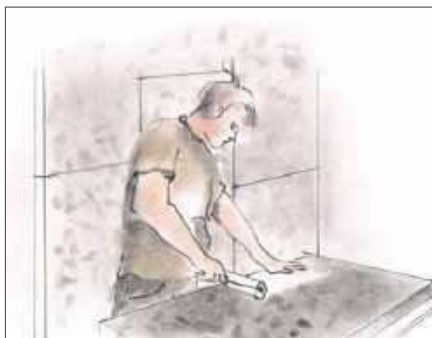
❷ Aplikacja kleju na wewnętrzną stronę płyty akustycznej.
