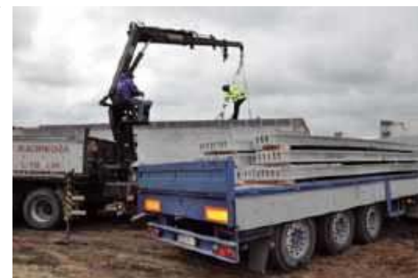
📌 Stropy prefabrykowane układa się korzystając z dźwigu, lub HDS-u, czyli samochodu ciężarowego z żurawiem. KONBET POZNAŃ
