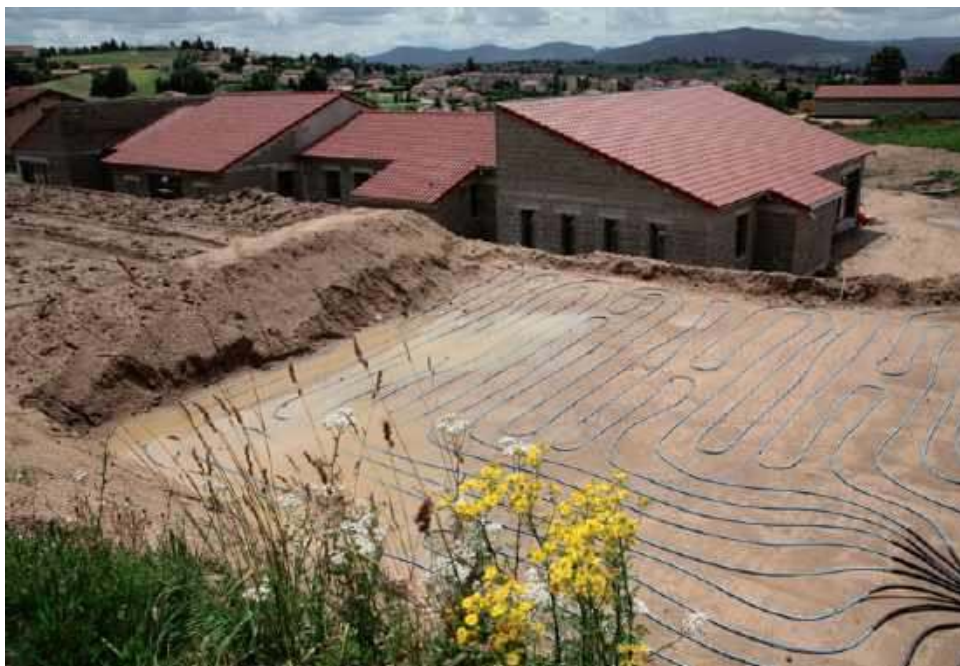
🔧 Pompy ciepła wykorzystujące ciepło z gruntu charakteryzują najniższe koszty eksploatacji. DE DIETRICH (SOFATH)
