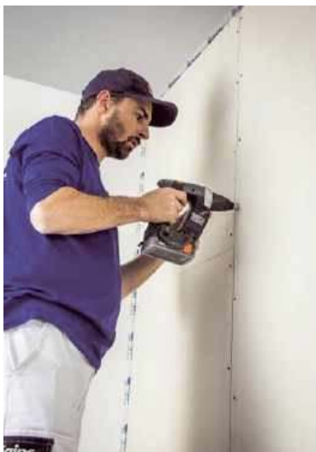
➦ Zastąpienie tradycyjnych tynków mokrych płytami gipsowo-kartonowymi znacznie skraca czas wykańczania ścian. RIGIPS
