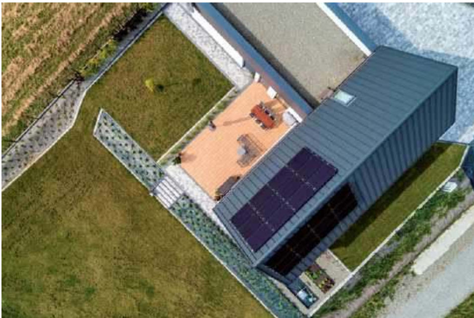
📍 Instalacja na różnych połaciach dachu to najtrudniejszy wariant, który wymaga specjalnego sterowania. W tym samym czasie bowiem część paneli może znajdować się w pełnym słońcu, a reszta w cieniu. HEWALEX
