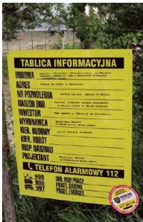
Według prawa budowlanego, każdy plac budowy ma być oznaczony tablicą informacyjną. A. PAPLIŃSKI
