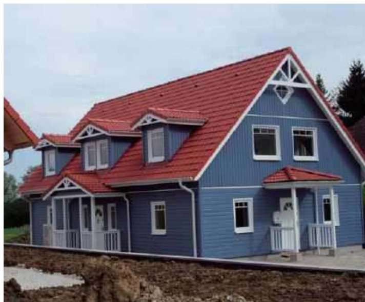
W domu dzielonym przez ustanowienie odrębnej własności lokali mieszkalnych mamy dwa osobne wejścia (jak na zdjęciu), albo wspólną klatkę schodową. ARCHIWUM BD
