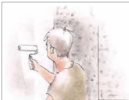
❶ Naniesienie kleju na oczyszczoną, suchą ścianę.
