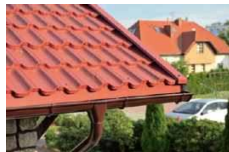
📍 Rynny stalowe pokrywa się wielowarstwowymi powłokami zabezpieczającymi, podobnie jak blachodachówkę. RUUKKI
