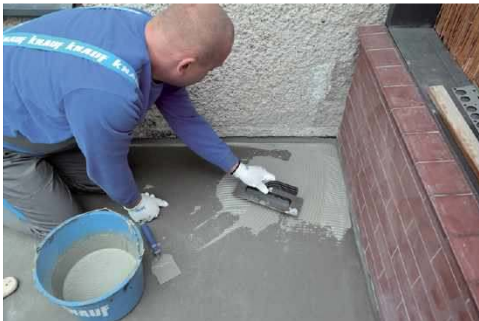
🔧 Izolację przeciwwodną aplikuje się w 2–3 warstwach. KNAUF
