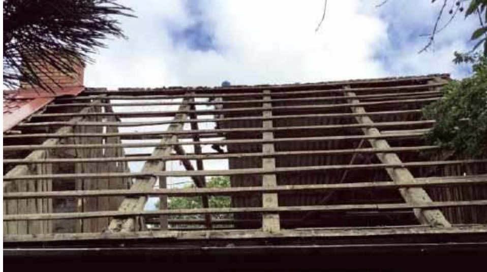
🔧 Rozpoczęcie prac powinien poprzedzić przegląd dachu, ze szczególnym uwzględnieniem stanu więźby. P. KONIKOWSKI
