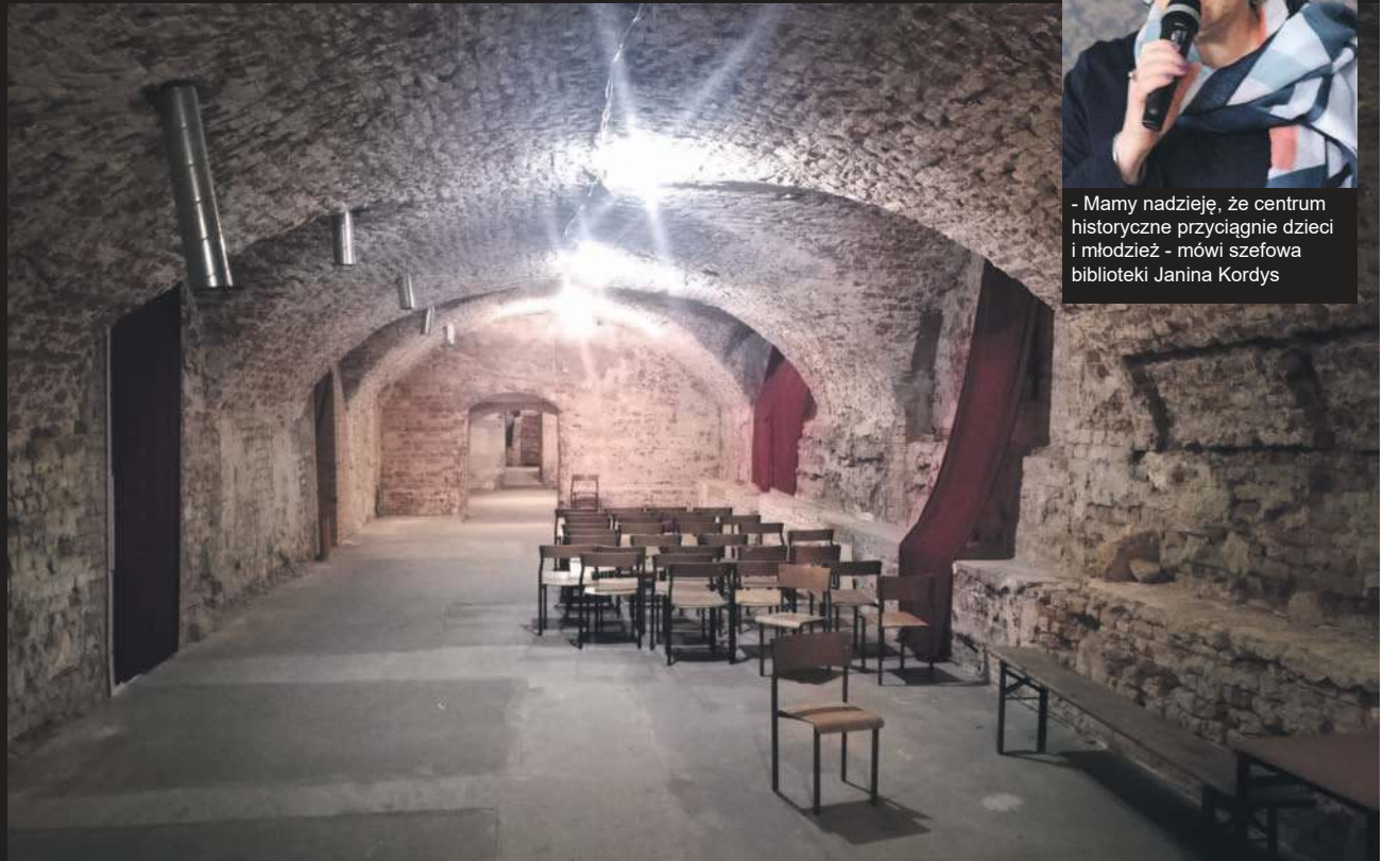
Ratuszowe piwnice - stan obecny
