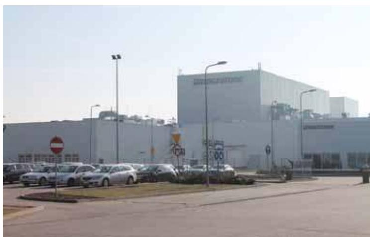
W Bridgestone doszło do pożaru silnika
