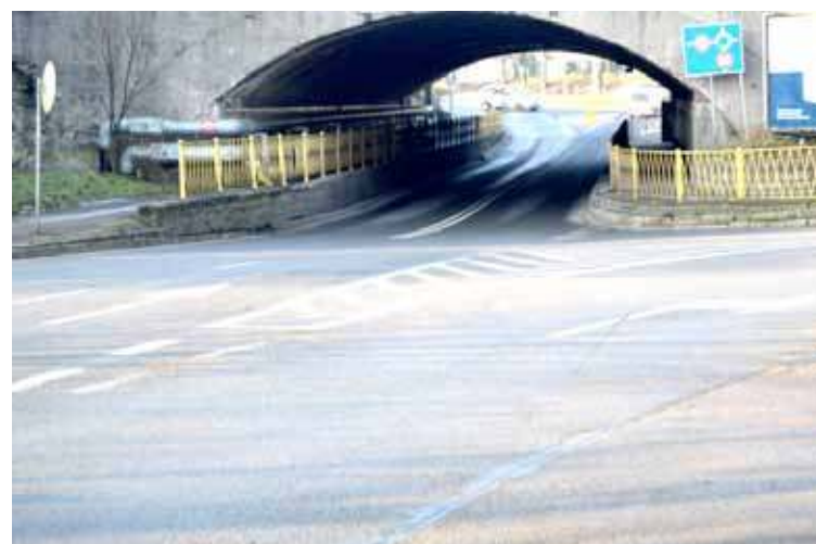
Dzięki nowoczesnej kanalizacji wiadukt przy Bogusława IV nie będzie już zalewany w czasie intensywnych opadów deszczu
