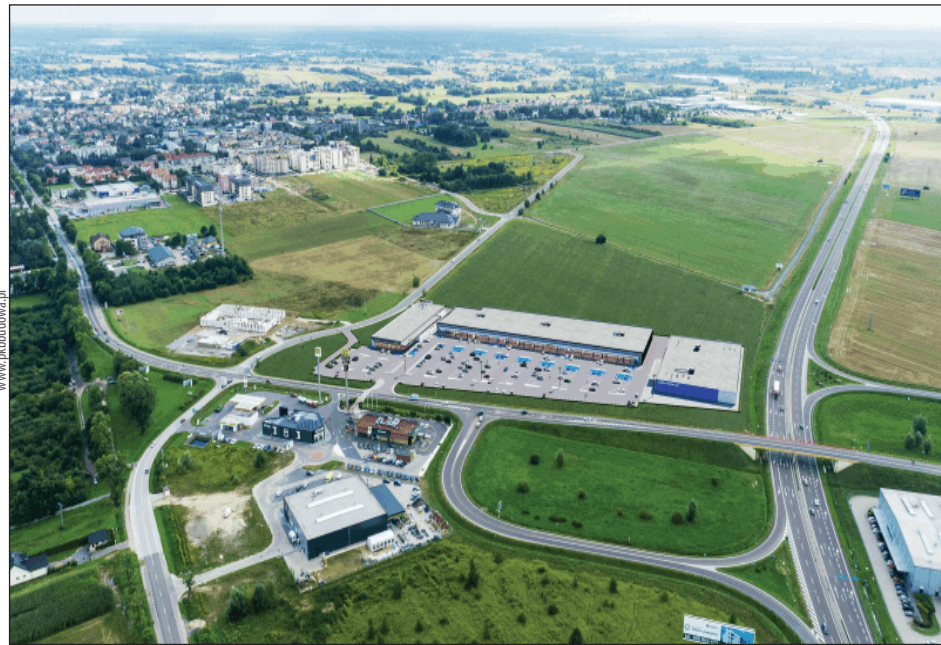
■ Teren inwestycji jest zlokalizowany wzdłuż ul. Trakt Lwowski - drogi biegnącej pomiędzy zjazdem z obwodnicy Garwolina, a ul. T. Kościuszki
