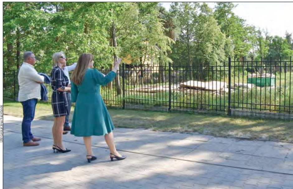
Na zakończenie spotkania pani burmistrz wraz z wykonawcą udali się na teren przeznaczony pod budowę hali sportowej
