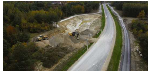
Końcowy fragment obwodnicy. W oddali widać rondo łączące ją z drogą do Staszowa.
