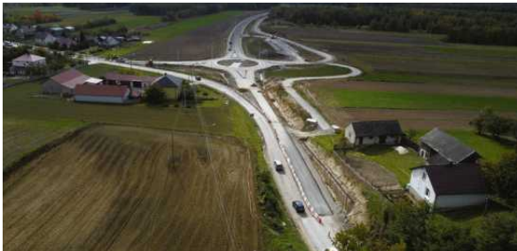
Początek obwodnicy. Rondo w miejscowości Kielczyna
