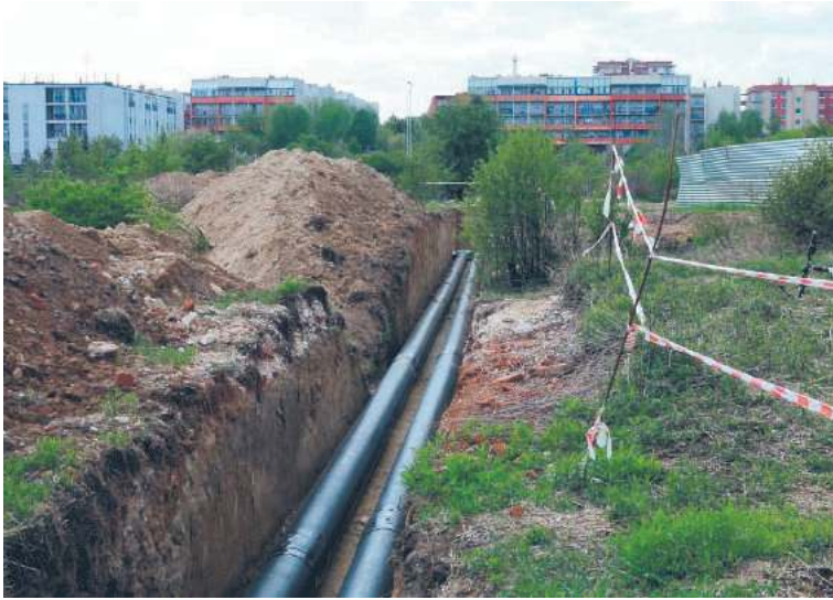
Według biegłych IPN szczątki odkryte w trakcie prowadzonych na górkach czechowskich wykopów pod położenie linii ciepłowniczej nie pozwalają stwierdzić, że to szczątki ludzkie i, że w tym miejscu były miejsca pochówku
