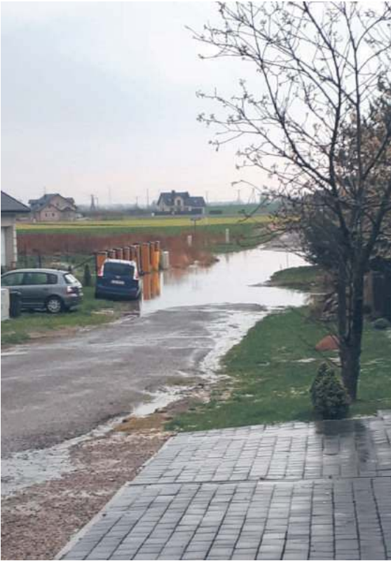
Tak wygląda skrzyżowanie ul. Skolimowskiej oraz ul. Rutkiewicz nawet po niewielkim deszczu
