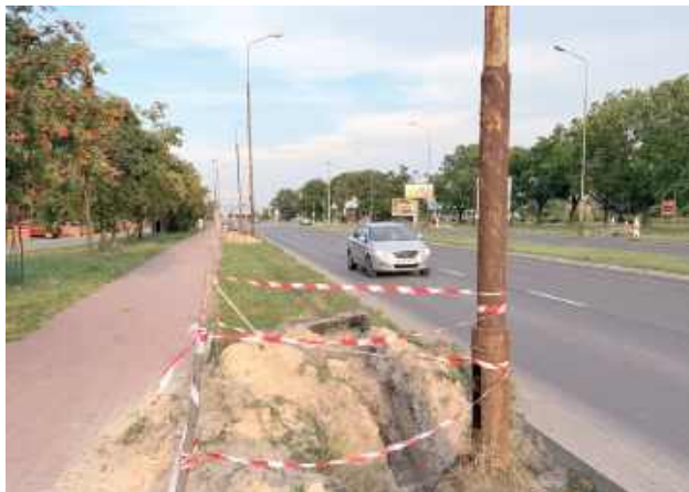
Nowoczesne oprawy oświetleniowe, które zostaną zamontowane przy alei Jana Pawła II, będą nie tylko bardziej efektywne, ale również energooszczędne
