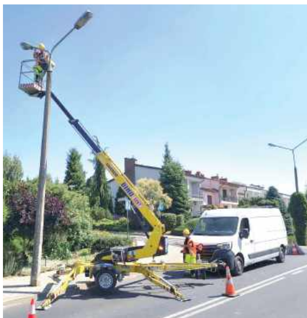
Nowoczesne, szare lampy o podłużnym kształcie są montowane bezpośrednio z koszy specjalistycznych podnośników samochodowych, co pozwala na zachowanie płynności ruchu drogowego podczas prowadzenia robót
