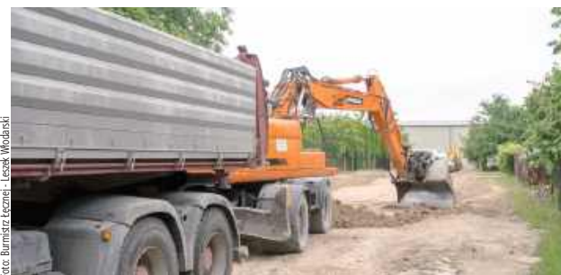
W Łęcznej rozpoczęła się modernizacja ul. Jakuba Staszewskiego
