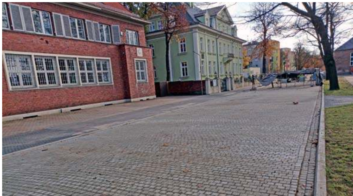
Prace remontowe na ul. Bankowej zakończą się z końcem listopada
