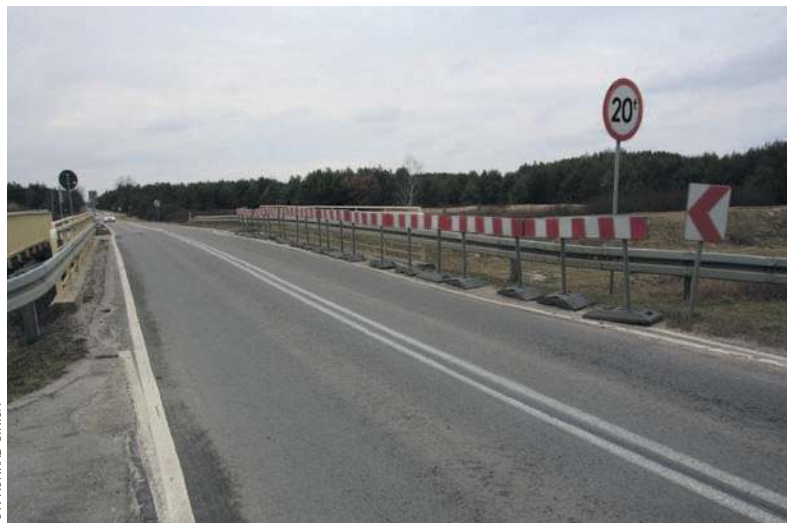
W miejscu istniejącej przeprawy w przyszłości powstanie nowy obiekt mostowy
