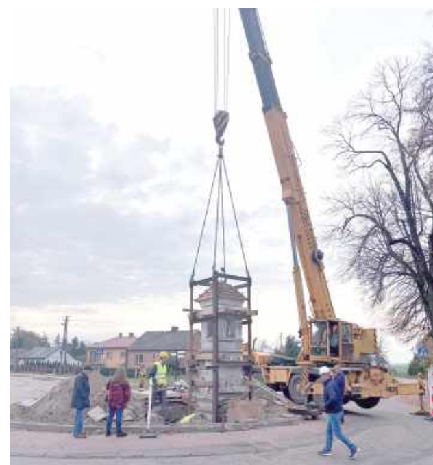
Prace już ruszyły
