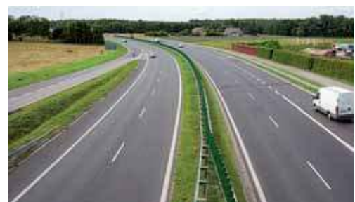
W Żałuskach (na zdjęciu fragment krajowej siódemki w tej miejscowości) powstanie ważny, drogowy węzeł
