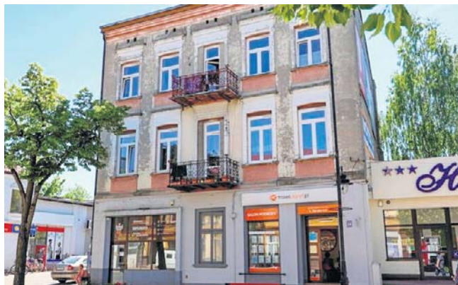
Kamienice zostaną zmodernizowane i podłączone do ciepłociągu
