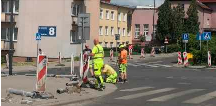
W piątek na skrzyżowaniu ul. Czwartek i Szkolnej pojawiła się grupa drogowców, która instalowała na chodniku z każdej ze stron kilkanaście słupków
