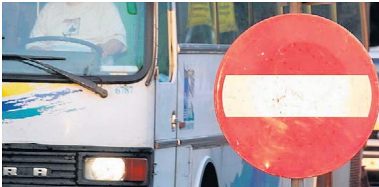
Prace drogowe objęły cały odcinek ul. Hallera. Na czas remontu wprowadzono ruch jednokierunkowy
