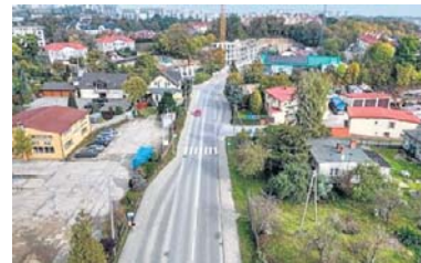
Przedsięwzięcie zakłada m.in. przebudowę jezdni i chodników
