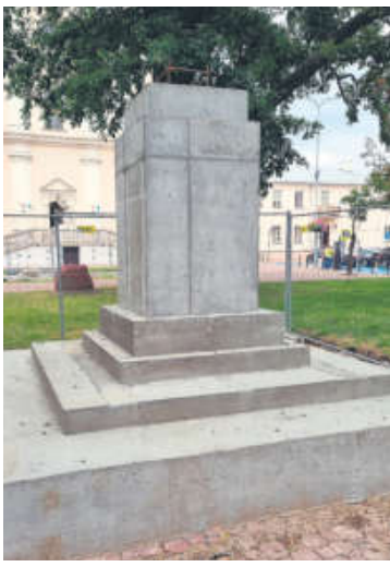
...i obecnie, w trakcie rekonstrukcji
