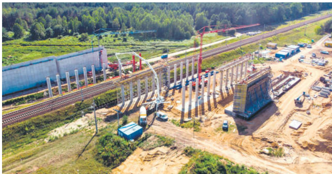
Budowa wiaduktu w Opolu Starym (sierpień 2022 r.)
