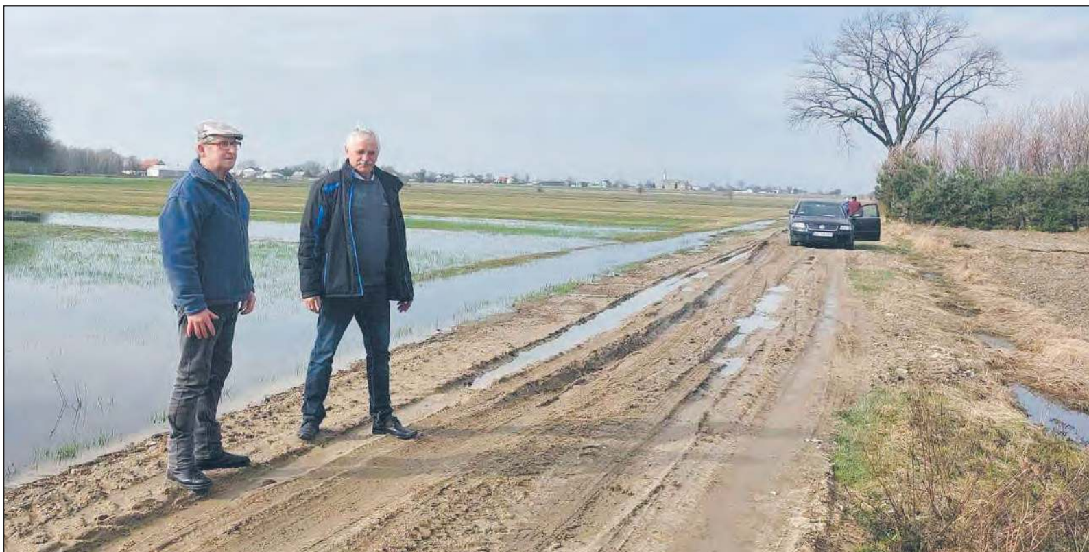
■ Po deszczach droga jest praktycznie nieprzejezdna. Na jej stan zwracają uwagę Eugeniusz Belka (z lewej) i Jerzy Domaszczyński
