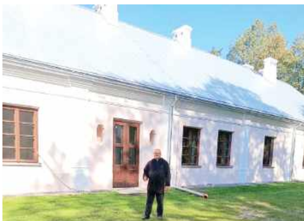
Remont dawnego klasztoru pobernardyńskiego w Jeleńcu. Ks. proboszcz Adam Daniluk informuje o postępach prac. W klasztorze zamontowano m.in. nowe drzwi
