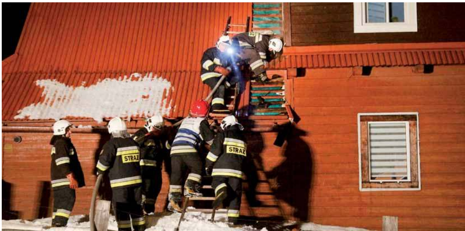
Konieczna była rozbiórka dachu.
