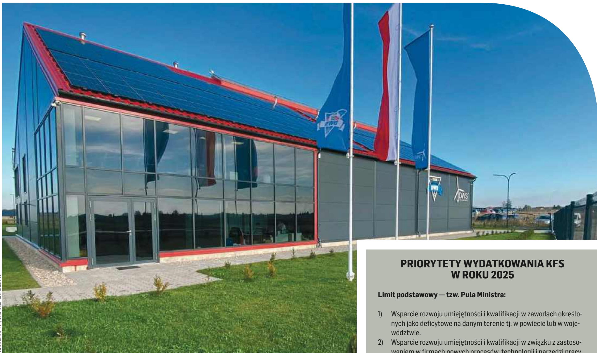
Fot. materiały firmy DWS Wind Turbine Service
