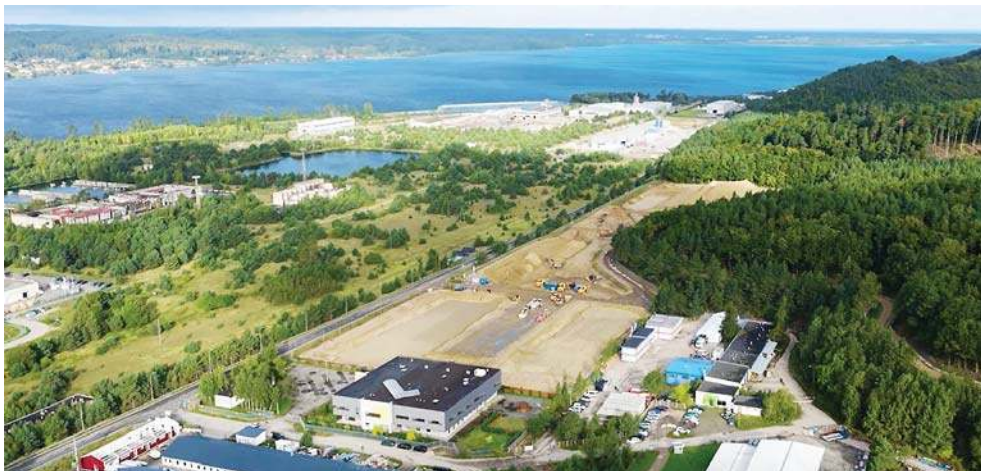
Magazyn Energii Żarnowiec budowany obok elektrowni w Żarnowcu
