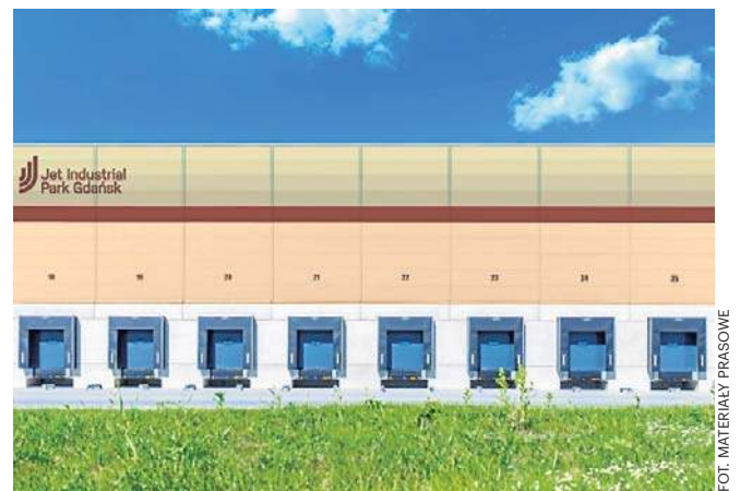
Magazyny, w które zainwestował Jet Industrial Lease zaoferują łączną powierzchnię najmu około 66 tys. mkw.
