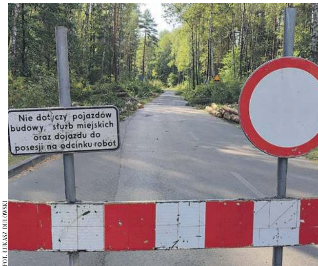
Rozpoczęła się przebudowa drogi gminnej przy Zalewie Chechło w Trzebini
