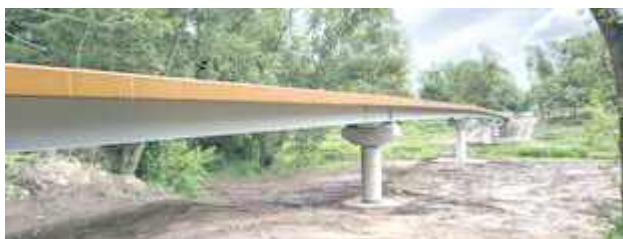
Prace nad budową kładki zmiernają ku końcowi
