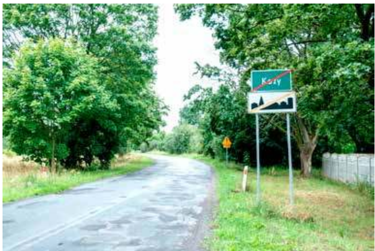
Będzie też remont na odcinku drogi z miejscowości Kozy w kierunku Dobrzan
