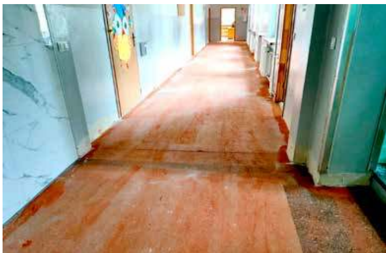
Jak się dowiadujemy, na parterze szkoły przy ul. Wielkopolskiej ułożona zostanie wykładzina PCV.
