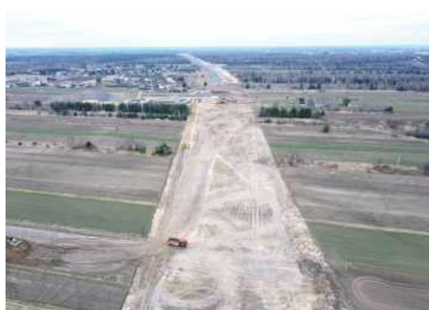
Budowa S19 Lubartów - Lublin. Marzec 2025 r.
