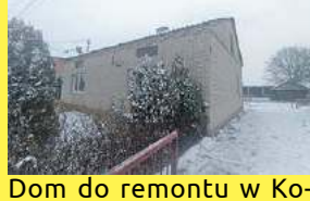
Dom do remontu w Komarnie, 604 494 489
