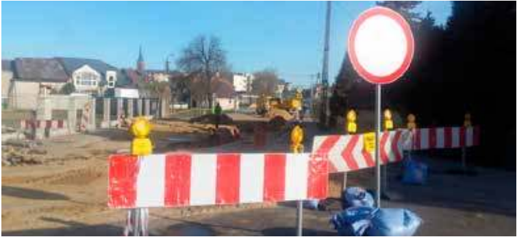
Na stoczkowskim odcinku drogi krajowej nr 76 trwają prace remontowe.
