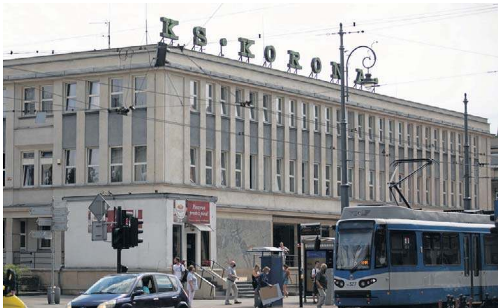
Niepewna jest przyszłość obiektów przy ul. Kalwaryjskiej
