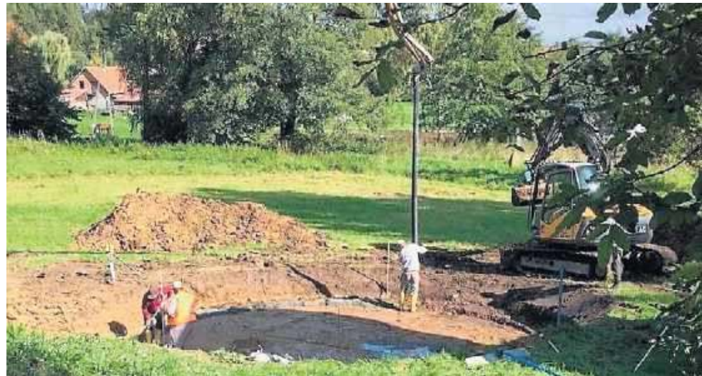
Budowa w Cichawie nowego zbiornika - o pojemności 150 m³ - potrwa do wiosny 2022 roku
